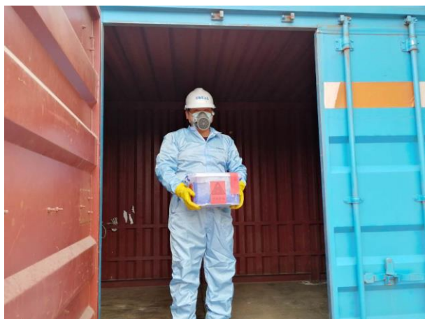
星浦学校危废处置现场
